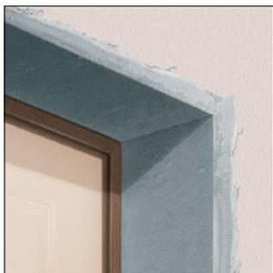
Оформление проёма штукатурной смесью для повышения звуко-термоизоляции и скрытия монтажных креплений. **Черновые откосы**
