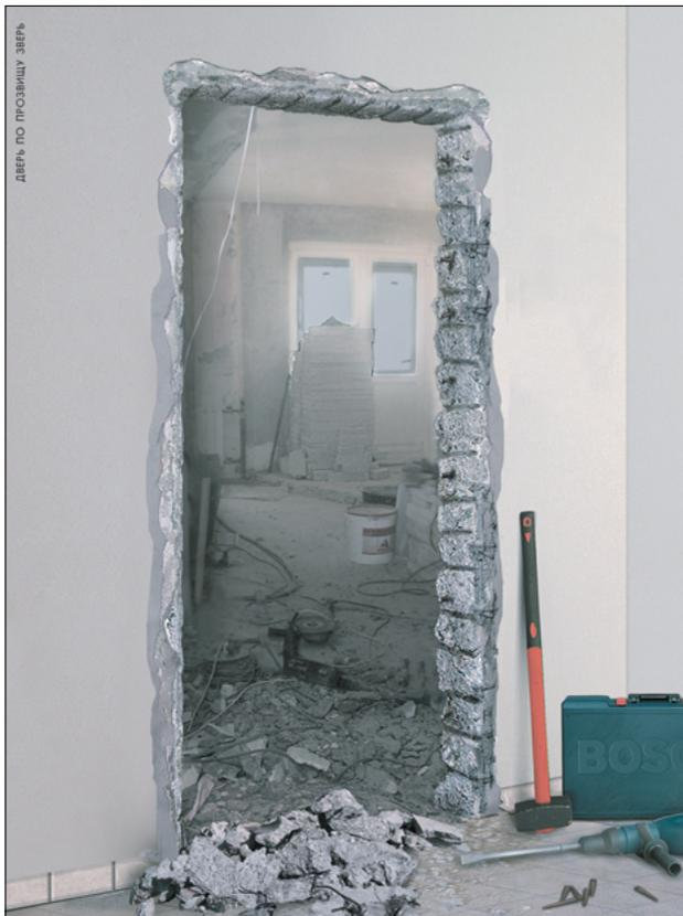
Часто в домах деревянные двери устанавливаются в бетонный проём, например в сериях домов П-3М, П-44Т, КОПЭ. Если установить в него стальную дверь, то ходовой проём получится около 700 мм, что не соответствует СНиП 21-01-97 и приказу МЧС РФ № 313. Чтобы установленная стальная дверь не противоречила этим нормам, требуется расширение проёма. Данный способ является наиболее экономичным.
