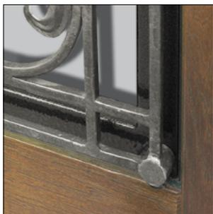
Крепёж кованой решётки к дверному блоку с помощью «бочонков» к уголкам обрамления стеклопакета
