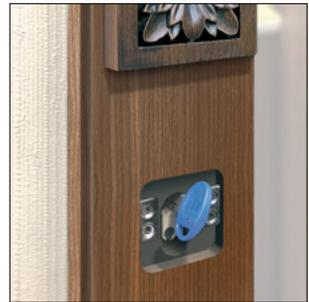
За съёмным декоративным элементом скрыт доступ к цилиндрическому механизму замка
